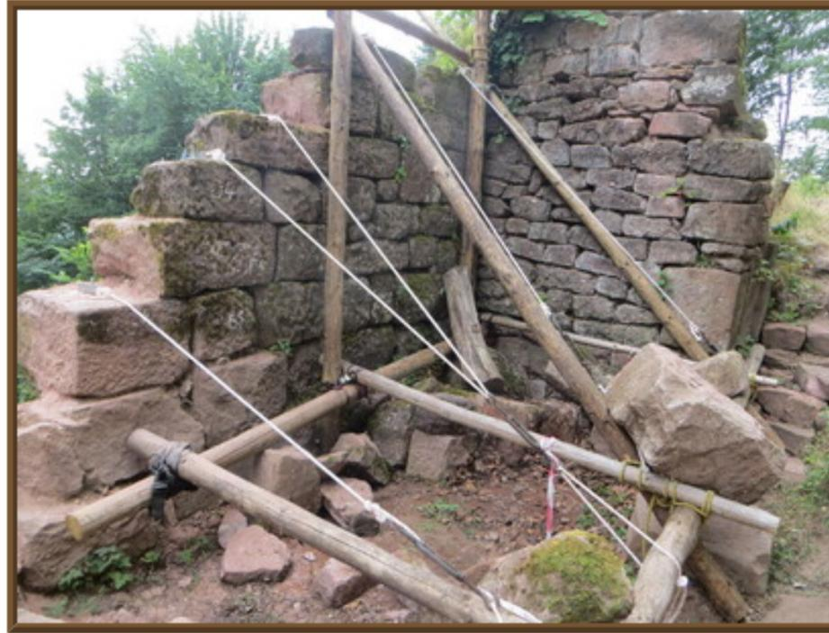
Après remontage du parement extérieur, blocage et rocaillage, l'échafaudage a pu être enlevé. Nous avons remonté le parement intérieur et rajouté quelques assises.
