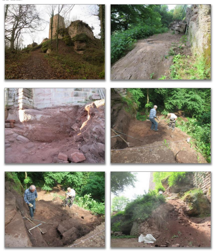
4 m sous le haut du rocher supportant le mur d'enceinte est apparue une plateforme en rocher prolongée par un pavage grossier au même niveau. Cette zone devait certainement être bordée au Nord par un mur malheureusement complètement écroulé. Nous reconstruirons ce mur en le renforçant à l'intérieur pour contrer la poussée de cette plateforme (voir plus loin "reconstruction du mur Lauter").
