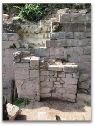
Le talus au pied du mur nous offrait une belle plateforme de travail. Pour prolonger le couloir de l'entrée nous l'avons bien sûr fouillée (voir plus loin) et ainsi trouvé les pierres tombées du mur, en particulier les pierres à double bossage faisant l'angle de 160° de l'arête. Ceci nous a permis de rajouter quelques assises.
