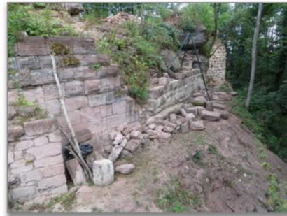
Vue par l'avant, le haut du parement intérieur très instable. Vue par l'arrière, certains blocs ne tiennent que par coincement.
