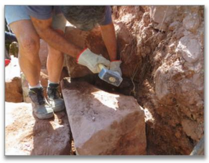
On voit ici la partie du mur d'enceinte qui pénètre vraiment dans l'entrée. Les blocs à bossage ont tous été démontés et remontés. On voit sur les photos le blocage en "arêtes de poisson" devait être l'arrière d'une voûte en berceau qui couvrait le couloir (voir rapport de sondage 2012 de Bernard Haegel) En dessous la structure maçonnée reposant sur le substrat rocheux et plaquée contre le mur d'enceinte sera aussi consolidée.
