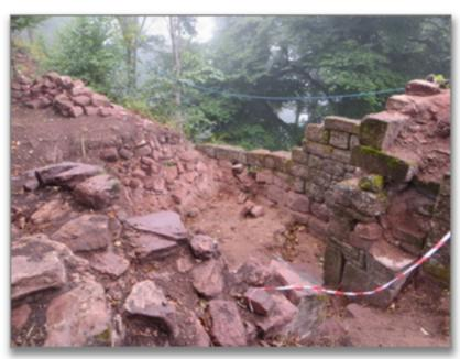
Nous avons construit un échafaudage pour maintenir en place le parement intérieur, puis avons numéroté et démonté les pierres de parement extérieur.
