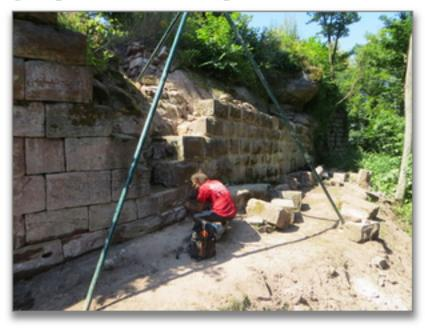
L'intérieur du mur étant très sablonneux nous avons essayé d'en enlever le maximum pour le remplacer par un blocage au mortier. Les pierres démontées devaient des fois être rectifiées à l'arrière pour remprendre leur place sans avoir à trop démonter le blocage existant.
