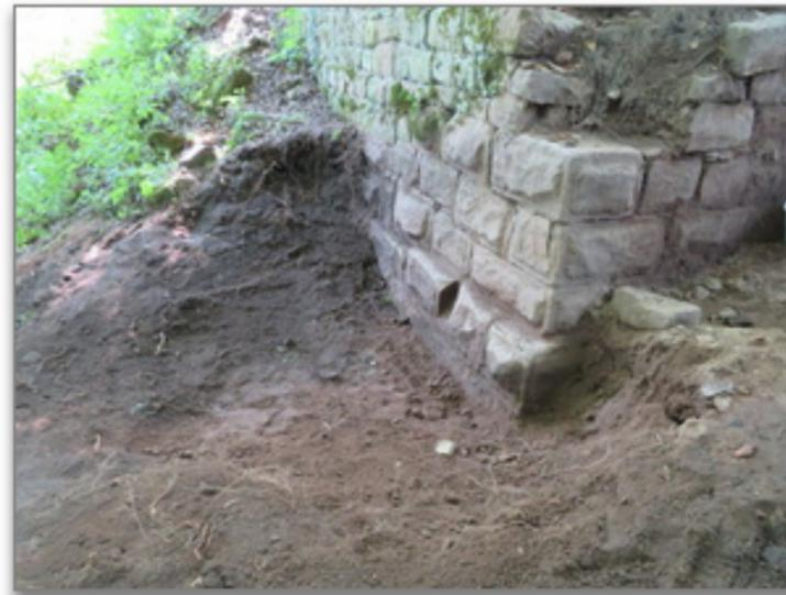
En déblayant la terre et les pierres amoncelées au pied de l'angle nous avons dégagé une plateforme et nous permettant de constater que la base de l'angle de la barbacane est vraiment saine et bien construite avec de beaux blocs à bossage qui se prolongent de chaque côté de l'angle, du moins pour les niveaux les plus bas.
