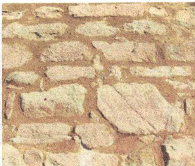
Exemple de rejointoiement à « pierre vue », laissant apparaître les calles d'origine, y compris les plus petites
