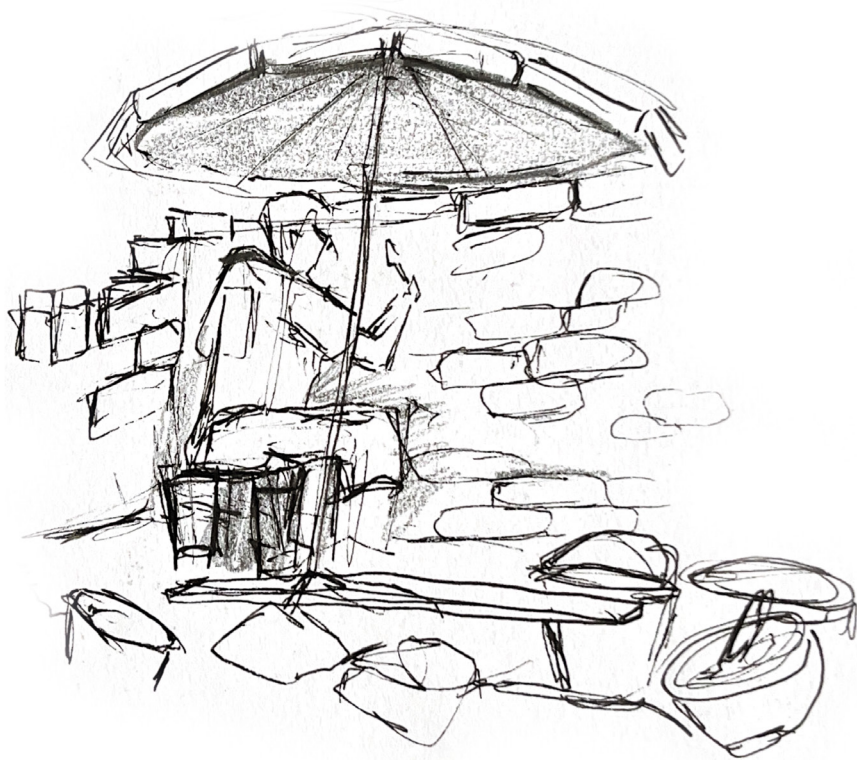
une bénévole travaillant les joints des murs de pierre
