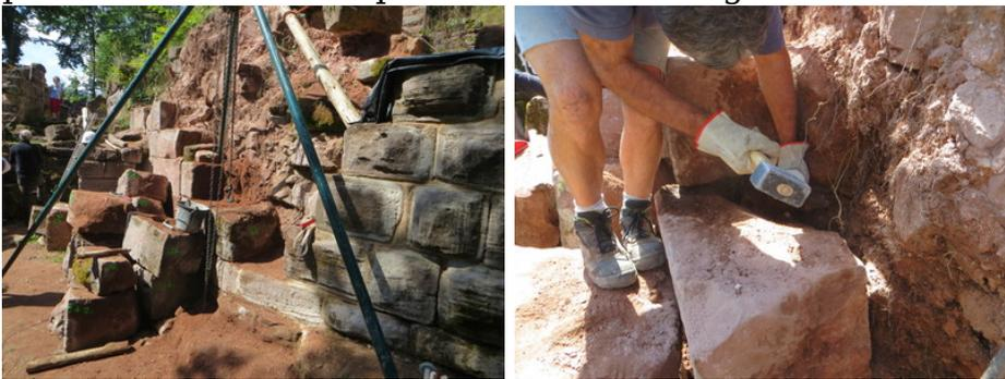
On voit ici la partie du mur d'enceinte qui pénètre vraiment dans l'entrée. Les blocs à bossage ont tous été démontés et remontés. On voit sur les photos le blocage en "arêtes de poisson" devait être l'arrière d'une voûte en berceau qui couvrait le couloir (voir rapport de sondage 2012 de Bernard Haegel) En dessous la structure maçonnée reposant sur le substrat rocheux et plaquée contre le mur d'enceinte sera aussi consolidée.
