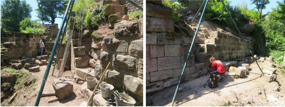
L'intérieur du mur étant très sablonneux nous avons essayé d'en enlever le maximum pour le remplacer par un blocage au mortier. Les pierres démontées devaient des fois être rectifiées à l'arrière pour reprendre leur place sans avoir à trop démonter le blocage existant.
