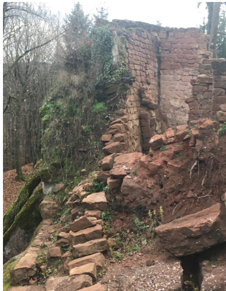
1 Forte fragilité du mur d'enceinte
