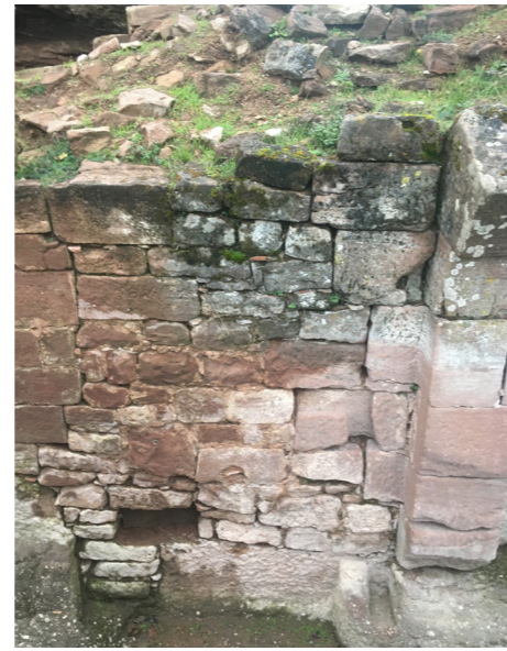
12 Lessivage des joints
