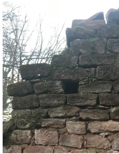
11 Lessivage des joints
