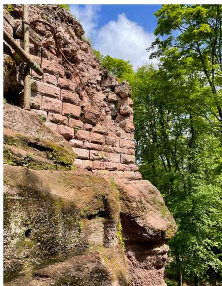
7 Effondrement des parements en pierre de taille
