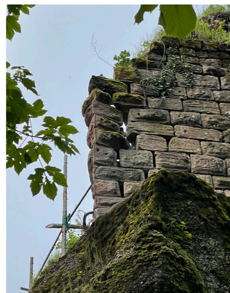
8 Détachement des parements en pierre de taille
