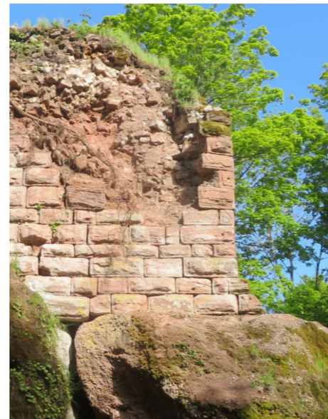
6 Effondrement des parements en pierre de taille
